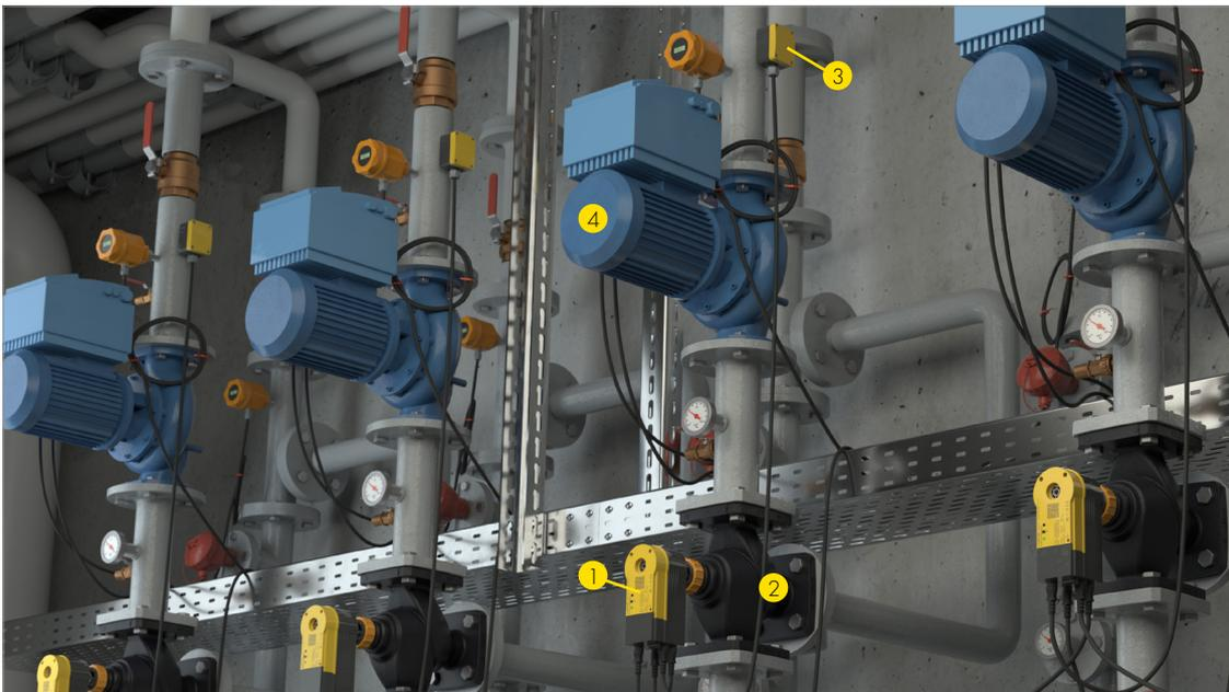
Exemple : Groupe de chauffage avec régulation de la température de départ
